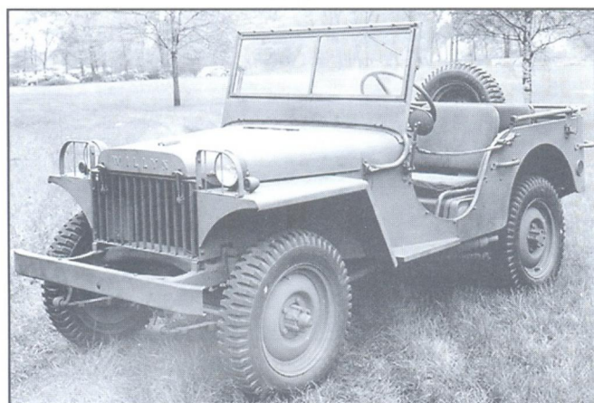
Виллис МА. Фары пока еще установлены на крыльях, что делало машину очень похожей на Бентам BR-C
